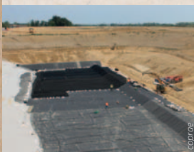
construction d'une alvéole
